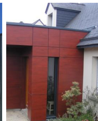
Bardage en composite bois-résine de type «Trespa»
