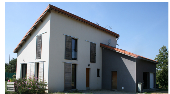
Toitures mono pente sur les constructions principales
